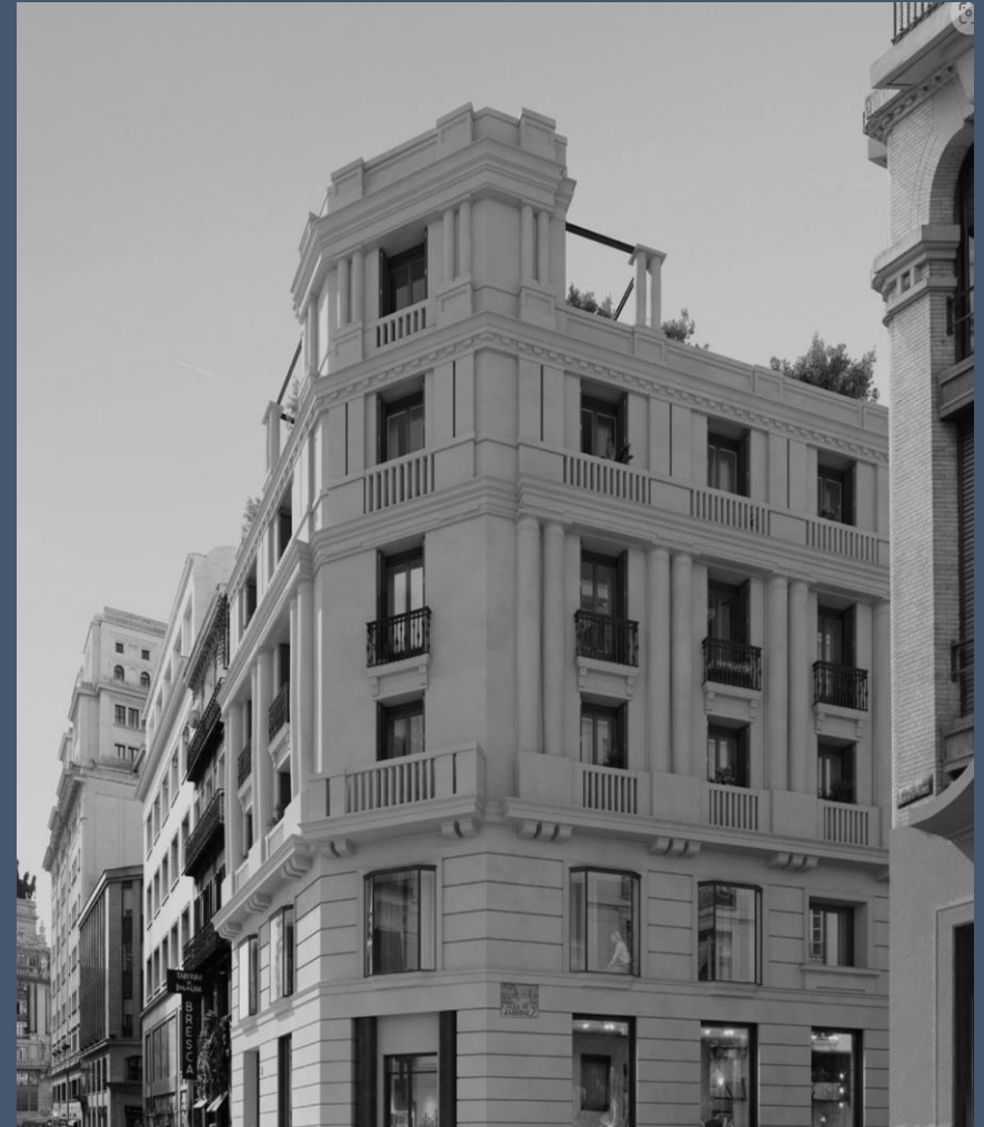
Virgen de los Peligros, Madrid. Edificio residencial 17 ud
